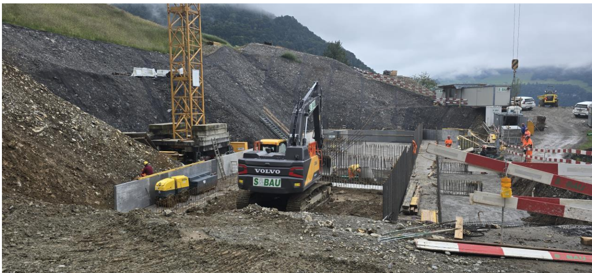
Bauarbeiten Schutzbauten Stockbachrunse im Breitloo
