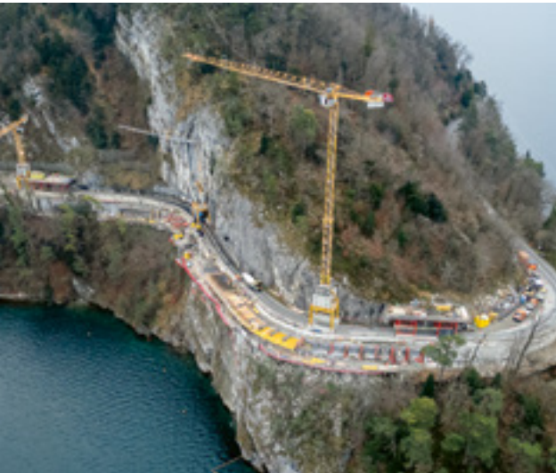
Sanierung der Strasse zwischen Gersau und Vitznau Quelle: Kanton Luzern
