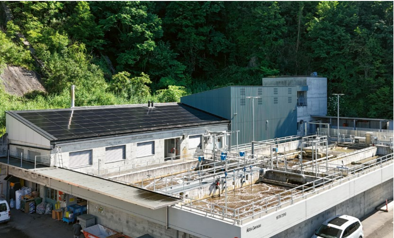
Neues Dach mit PVA über den Betriebsräumen – ARA Gersau
