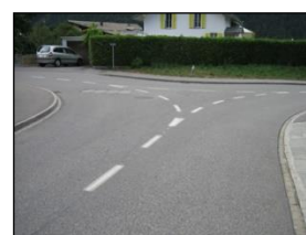
Besondere Markierung zur Verdeutlichung des Rechtsvortritts
