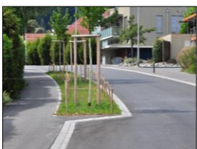
Seitliche Einengung (Horizontalversatz)
