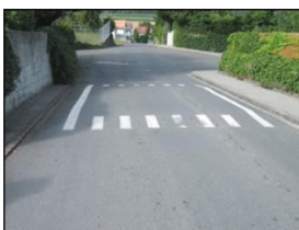
Asphaltkissen (Vertikalversatz)
