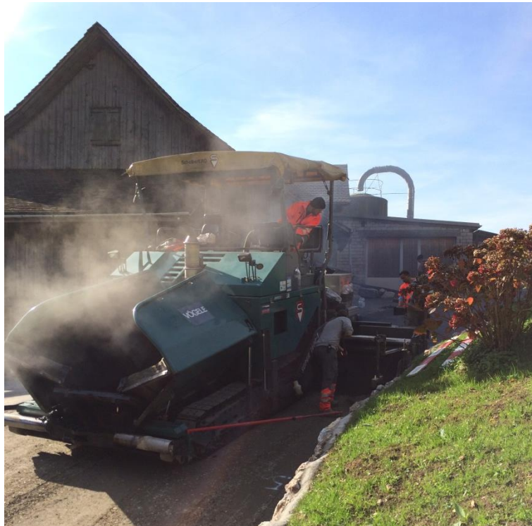
Belagseinbau am 4. November 2016 beim Rotacher
