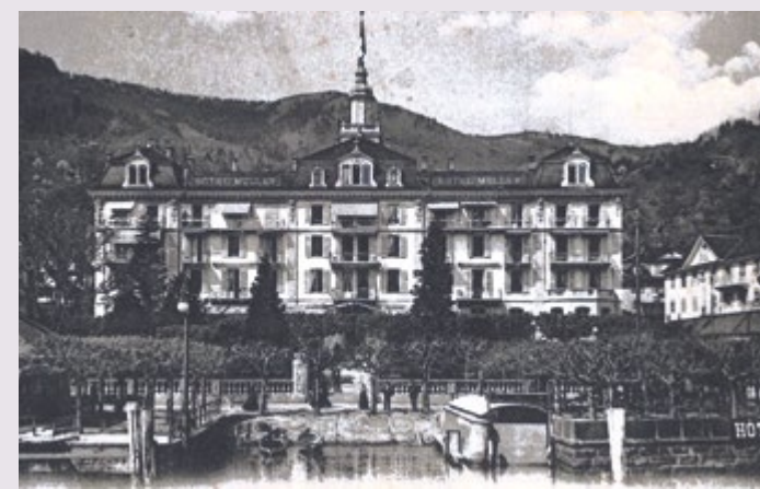
Hauptfassade nach Umbau von 1891, Ansichtskarte ca. 1903
